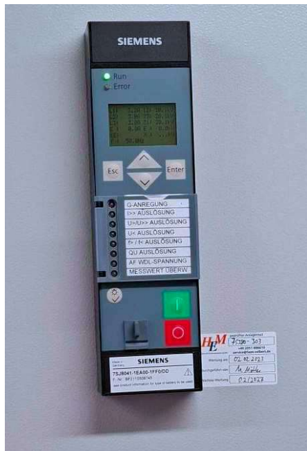
Bild 2.1: Überstromzeitschutz-Relais am NVP/NAP
